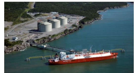
Canaport LNG (Repsol Energy North America)
